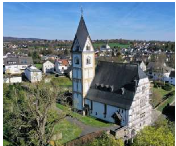
Das Gerüst an der Westfassade wurde im Mai abgebaut. Nun strahlt sie wieder im neuen Glanz. Foto: Engler
